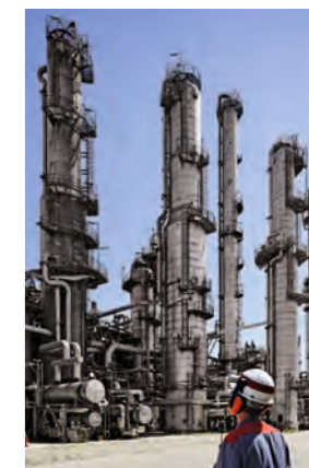
Die Mineralö Raffinerie Oberrhein in Karlsruhe ist Deutschlands größter Benzinerzeuger. Im Bild sind die für eine Raffinerie typischen Destillationskolonnen (hier eine Gasnachverarbeitungsanlage) zu sehen.
