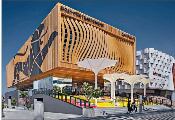
Die Holzfassade des Baden-Württemberg-Hauses auf der „Expo Dubai“ verbirgt eine hybride Konstruktion aus Stahl und Holz. Fotos: Nüssli/keller-fotografie.de
