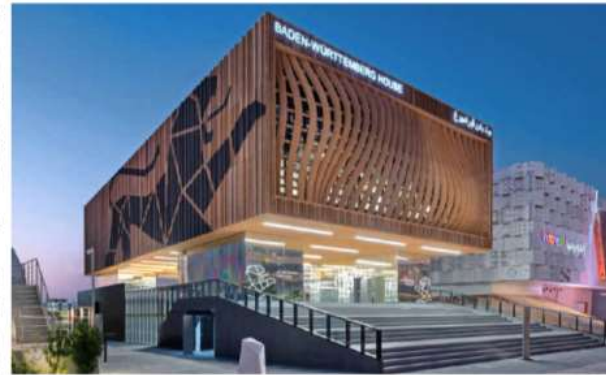
Das Baden-Württemberg-Haus auf der Weltausstellung in Dubai sollte beispielgebend für die heimische Ingenieurbaukunst und Architektur aus dem Südwesten sein.
