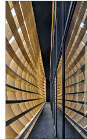
Vorgesetzte Fassade aus 186 individuell gefertigten Fichtenlamellen
