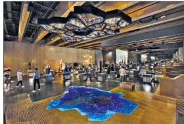
Für die tragende Konstruktion durfte Holz im Dach eingesetzt werden, deren doppelte Brettschichtholzträger im Innenraum sichtbar bleiben.
