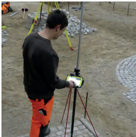
Abb. 2: Aufstellen des Tachymeters (Foto: KOMZET BAU BÜHL)
