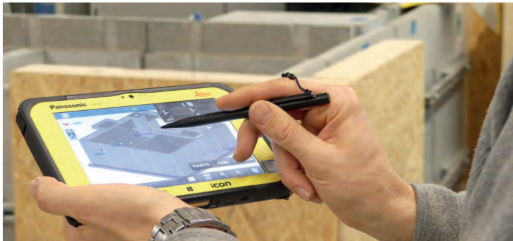
Abb. 5: Montage des Fertigteilkellers mit dem Tachymeter (© KOMZET BAU BÜHL)
